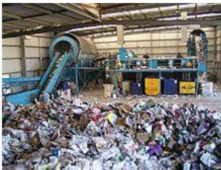
Рис. 1 Завод по сортированию мусора в Австралии
